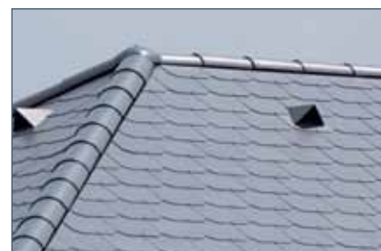
Velikost výstupního otvoru větrací hlavice je 100 cm 2 /iks.
