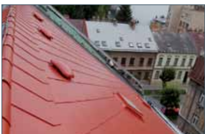
Větrání střešního pláště je realizováno plastovými hlaviciemi.
