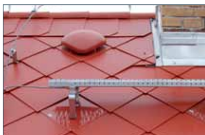
Velikost výstupního otvoru plastové větrací hlavice je 200 cm 2 /iks.
